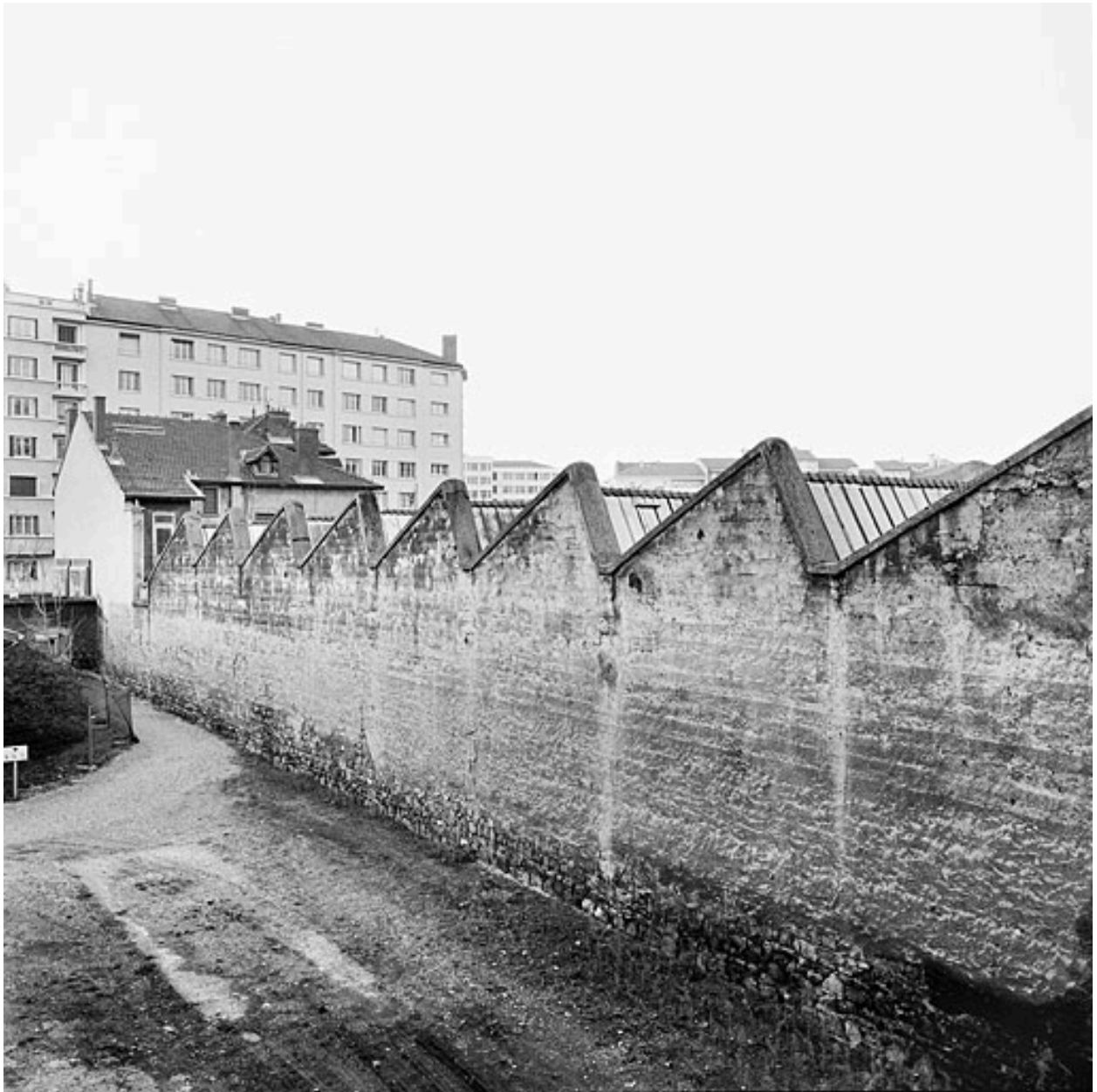
Vue nord-est des ateliers et sheds
