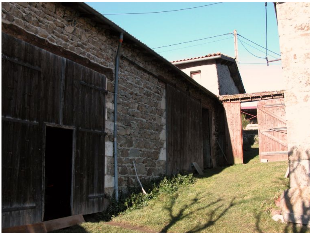
Grange-étable et portail de la cour au fond.
