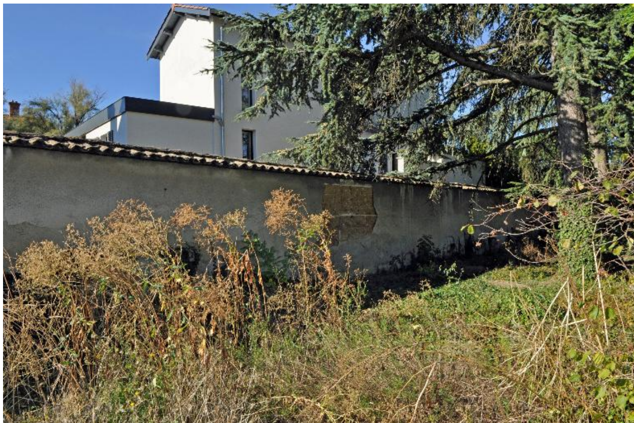
Mur de clôture sud, en pisé enduit
