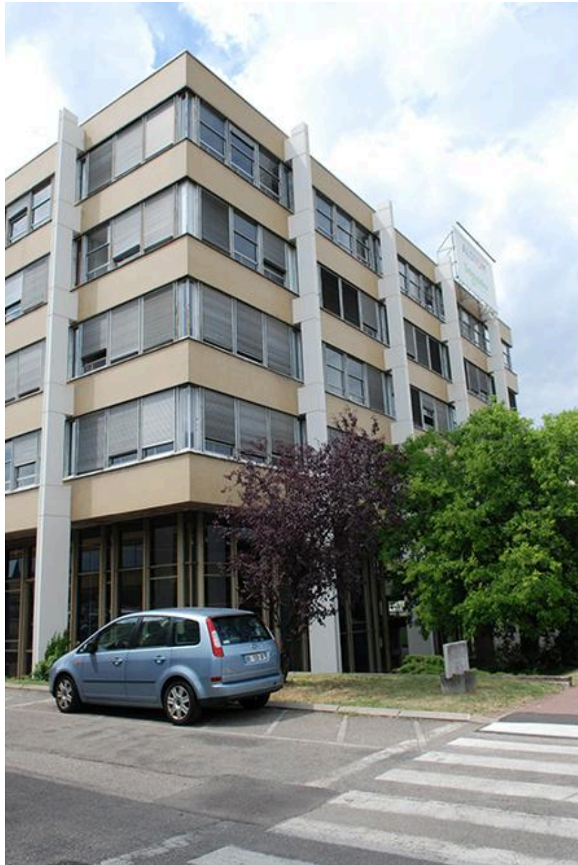
Détail structure du bâtiment administratif
