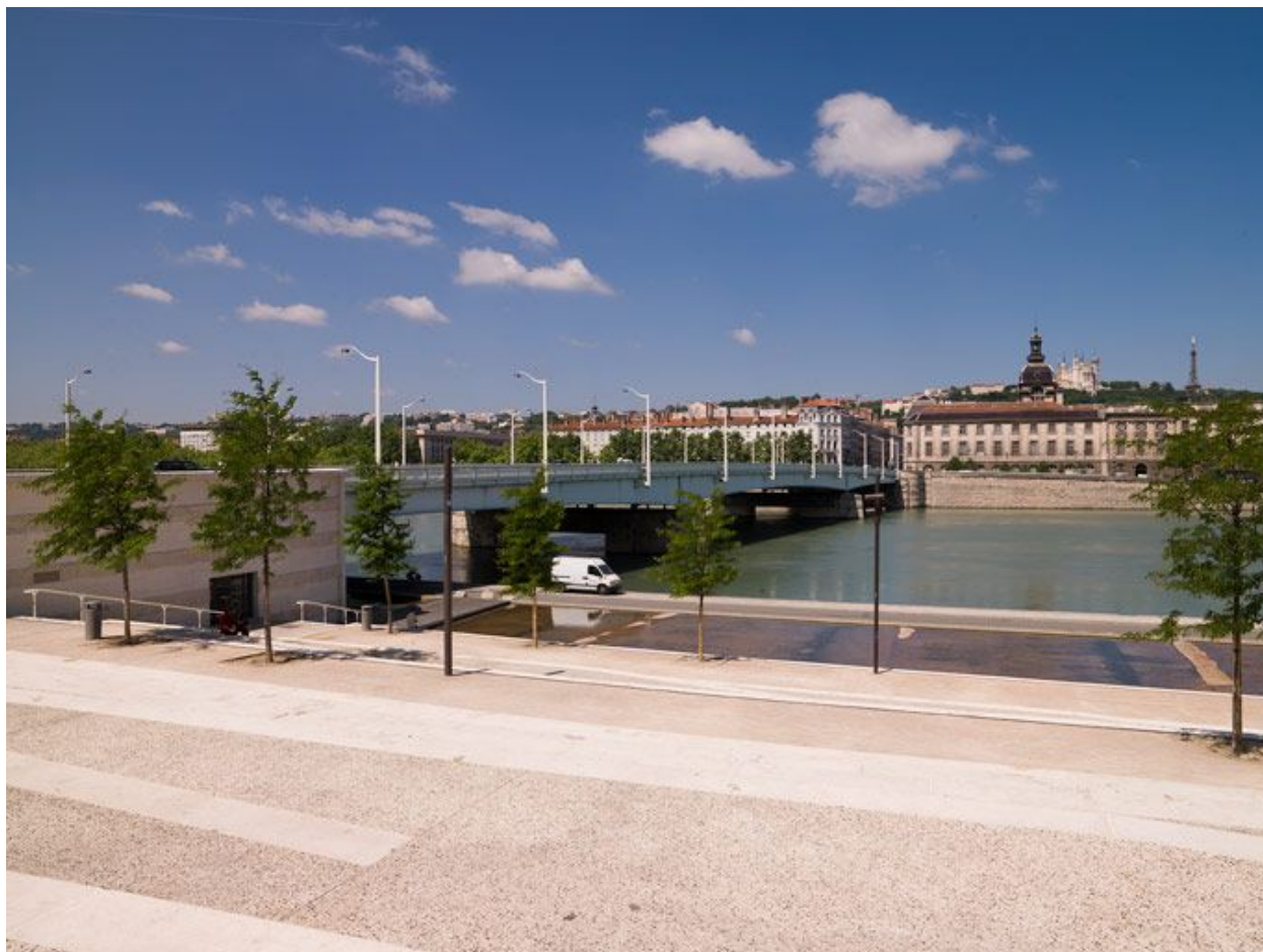
Vue du pont et de l'hôtel-Dieu depuis le nord-nord-est
