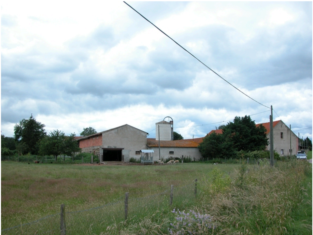
Vue générale depuis l'est.
