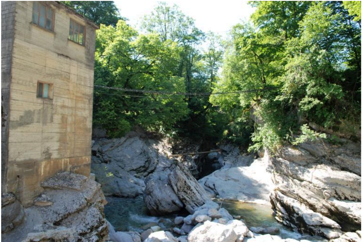
Micro-centrale hydroélectrique au-dessus du Chéran
