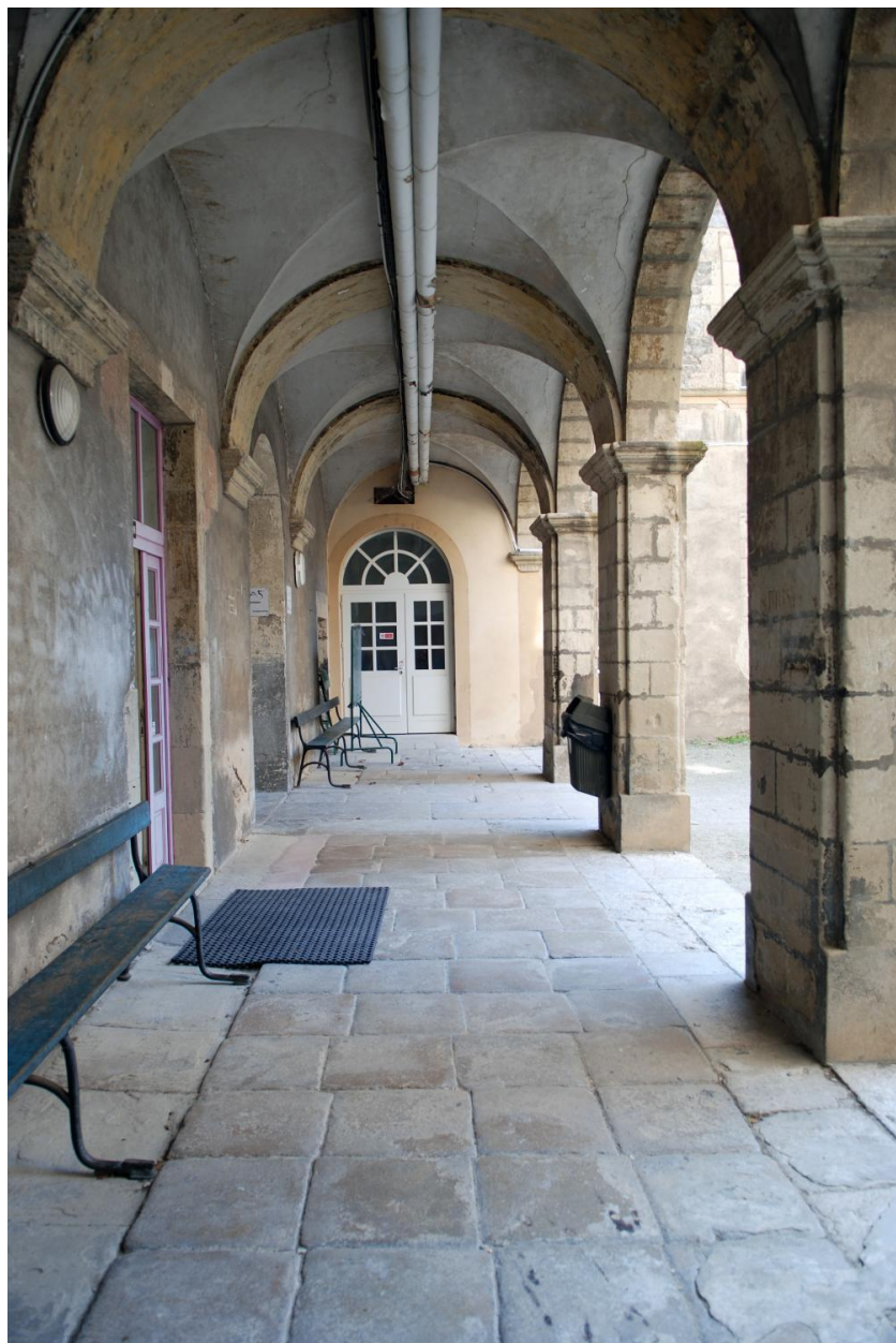
Bâtiment A, cour, galerie sud vue depuis l'est
