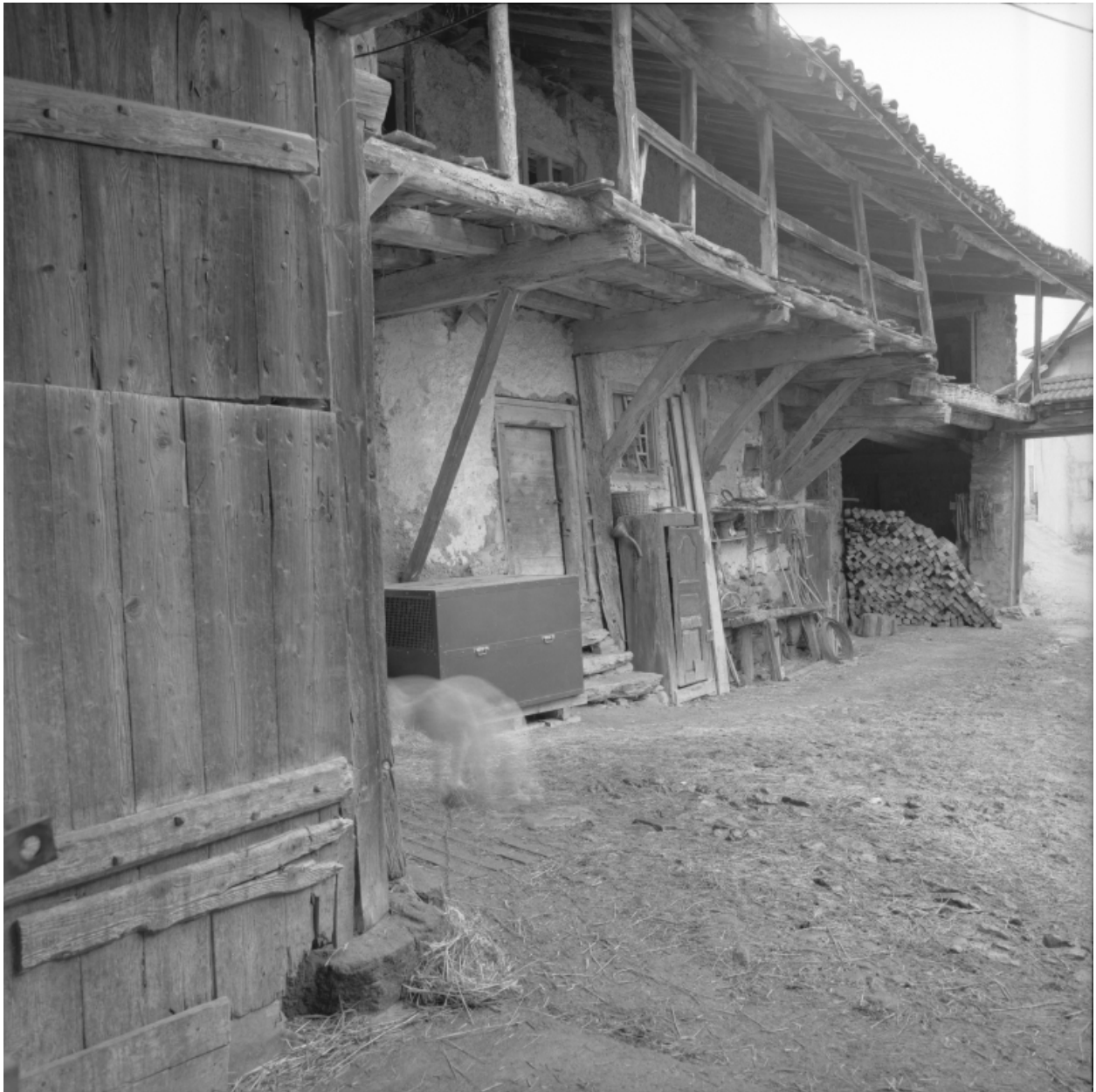
Vue d'ensemble du logis, depuis la cour, de trois-quarts gauche.
