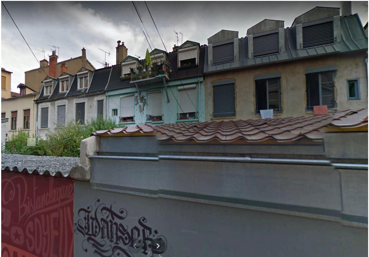
Vue d'ensemble Est
