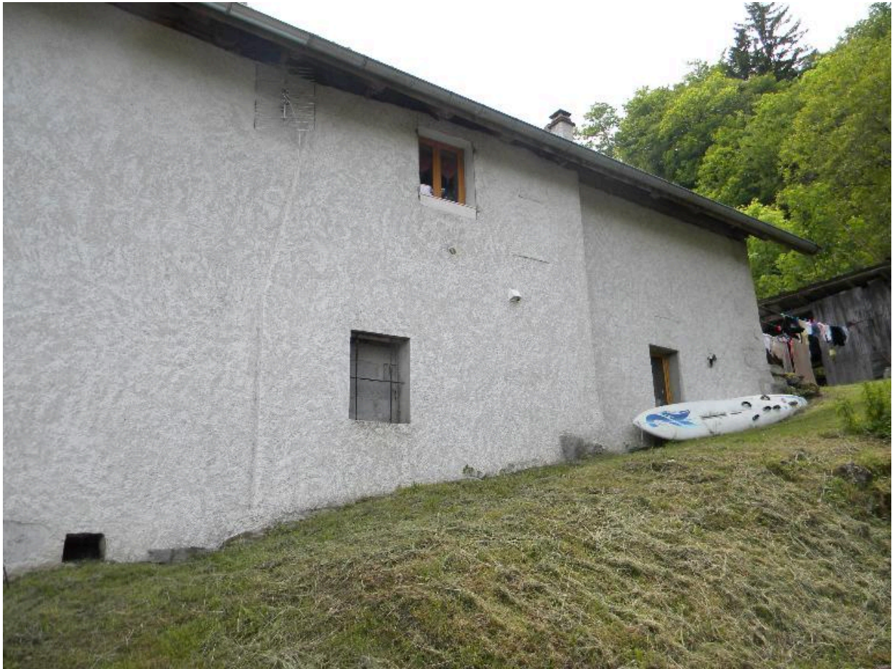
Vue de la façade nord d'une ancienne ferme (2008 B7 1163).
