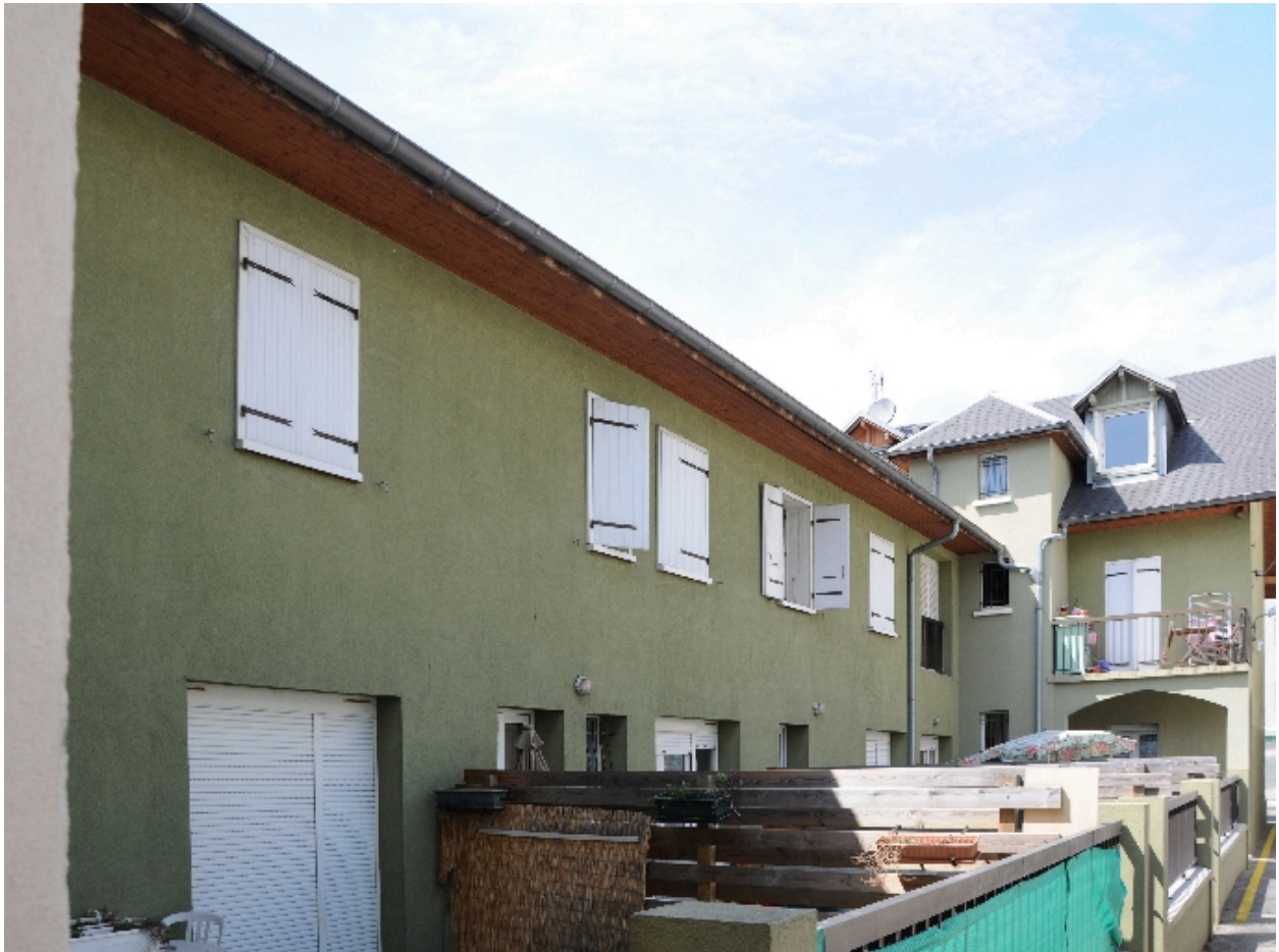
Vue depuis l'arrière
