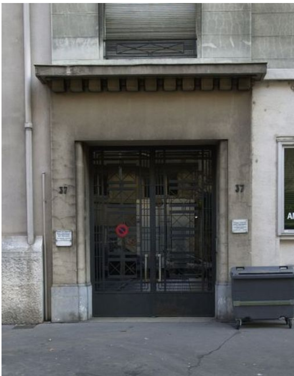
Vue extérieure de la porte d'entrée
