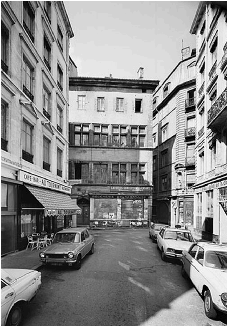
Rue Mercière : vue générale depuis la rue Ferrandière en 1976
