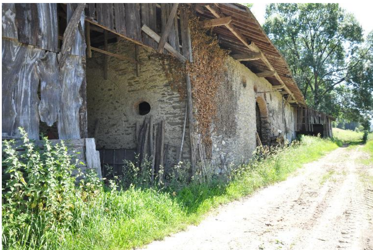
Façade est du bâtiment.
