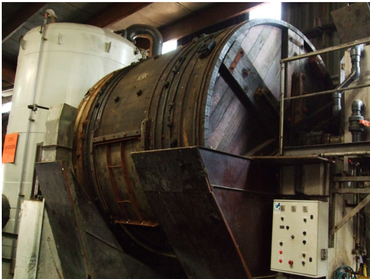
Vue d'ensemble de la tannerie : machines
