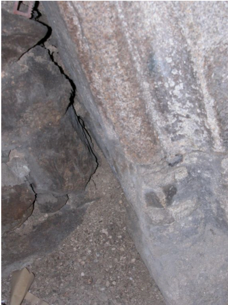
Détail de l'encadrement mouluré de l'espace aménagé au sud, piédroit ouest.
