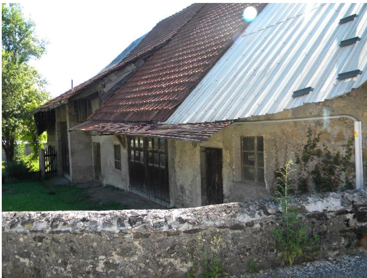
Vue de la façade sud-ouest de l'ensemble
