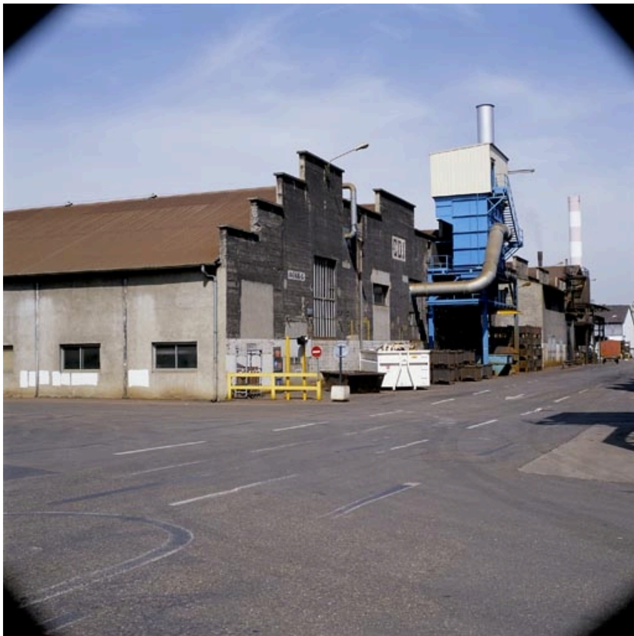
Fonderie, vue nord, parachèvement sud près de la porte C.
