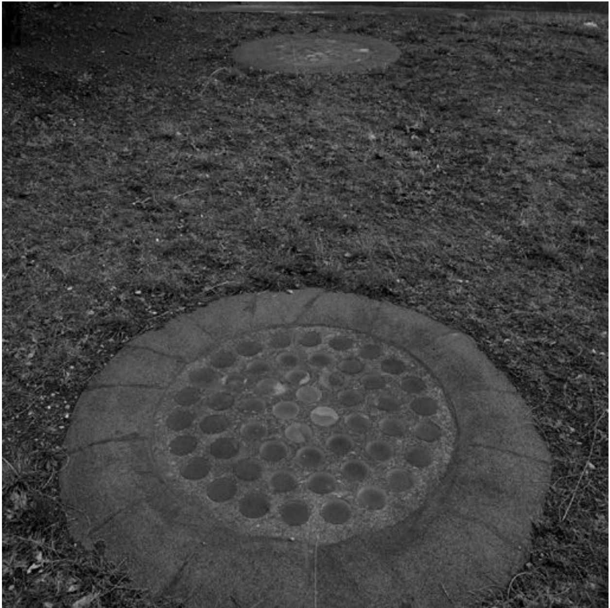
Le bâtiment 17, pavillon du directeur : détail des pavés de verre éclairant les galeries souterraines subsistant dans le jardin
