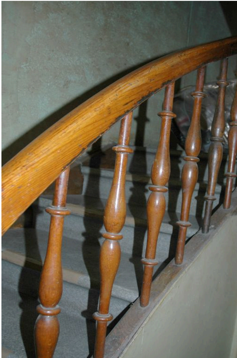
Garde-corps de la rampe d'escalier avec barreaux en bois tourné à fuseaux, 12 quai L'Astrée.
