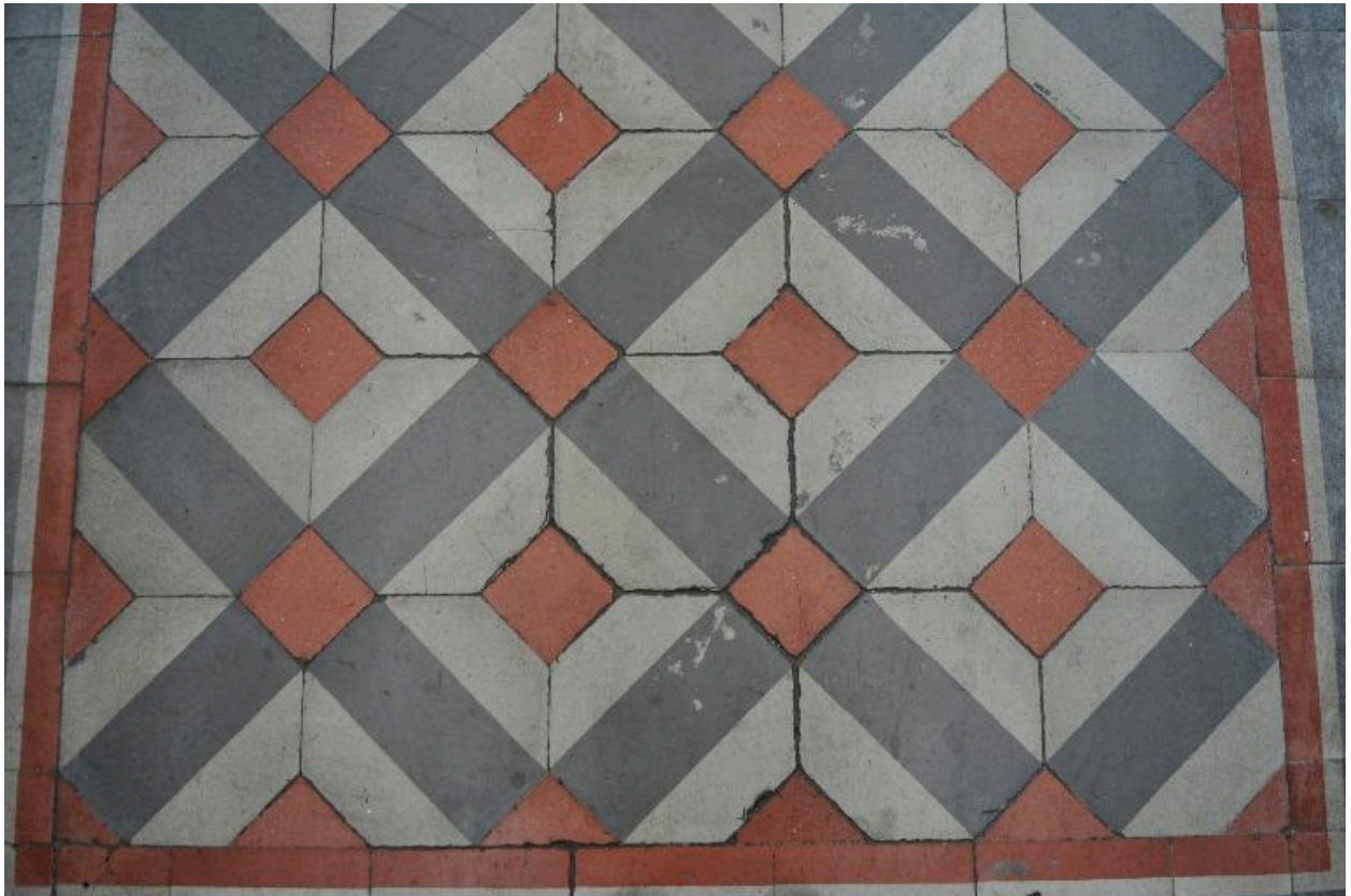
Vue intérieure, détail du pavement de l'allée
