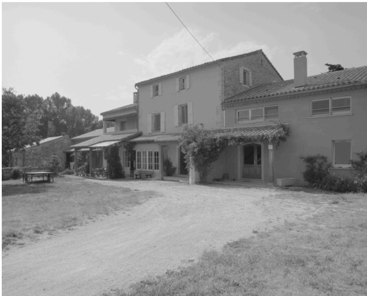
Les Planches, quartier Béal. Elévation principale.
