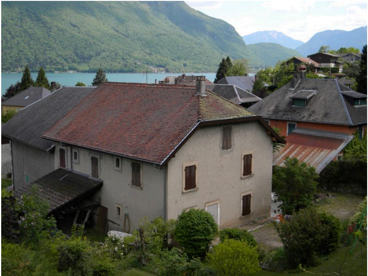
Vue de la partie sud du hameau depuis la piste cyclable.
