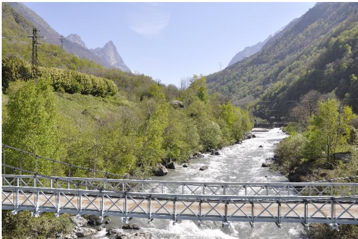
Vue de la passerelle traversant la Romanche
