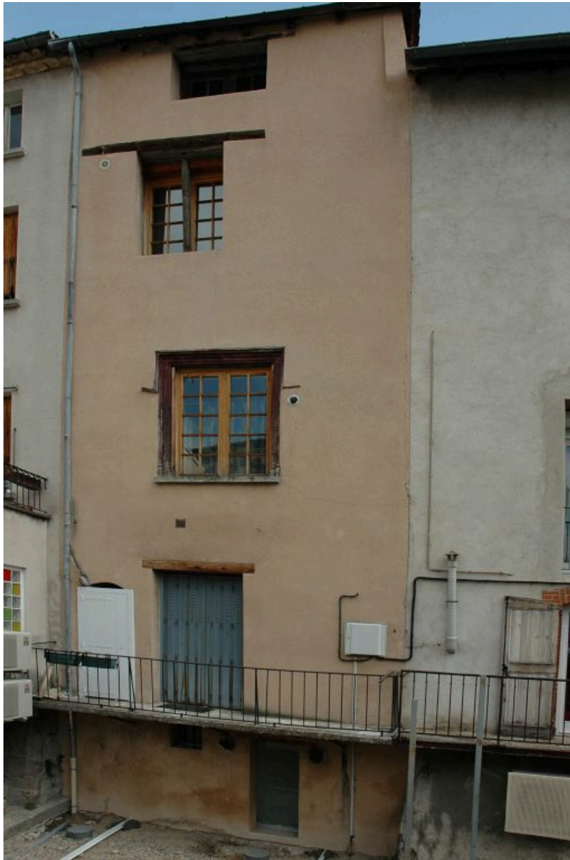
Elévation postérieure du côté de la rivière.
