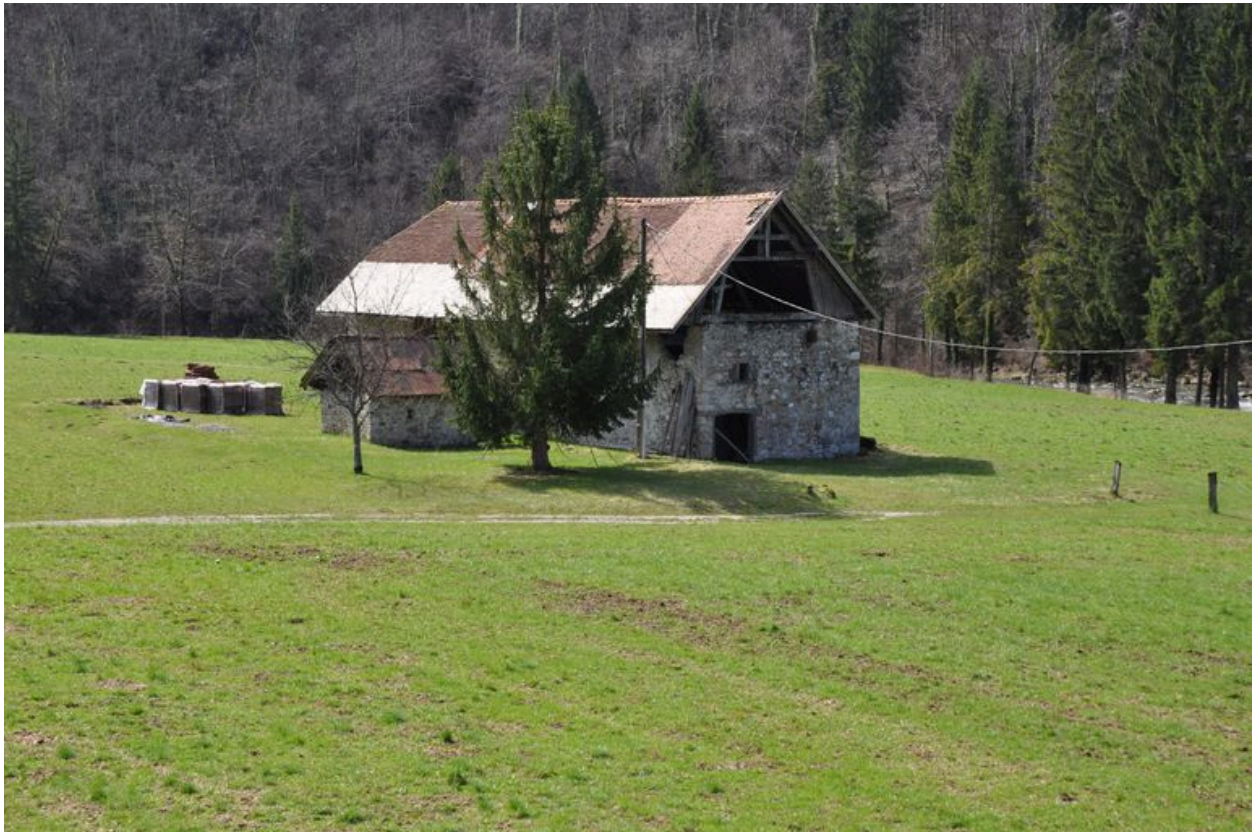
Vue générale du moulin Onnex
