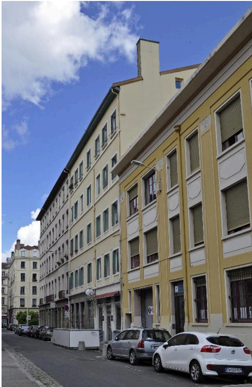
Vue d'ensemble de l'élévation sur rue
