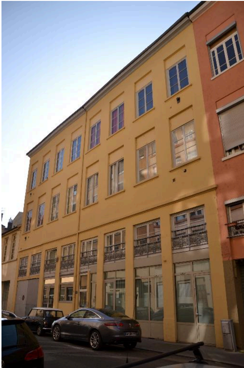
Vue d'ensemble façade nord
