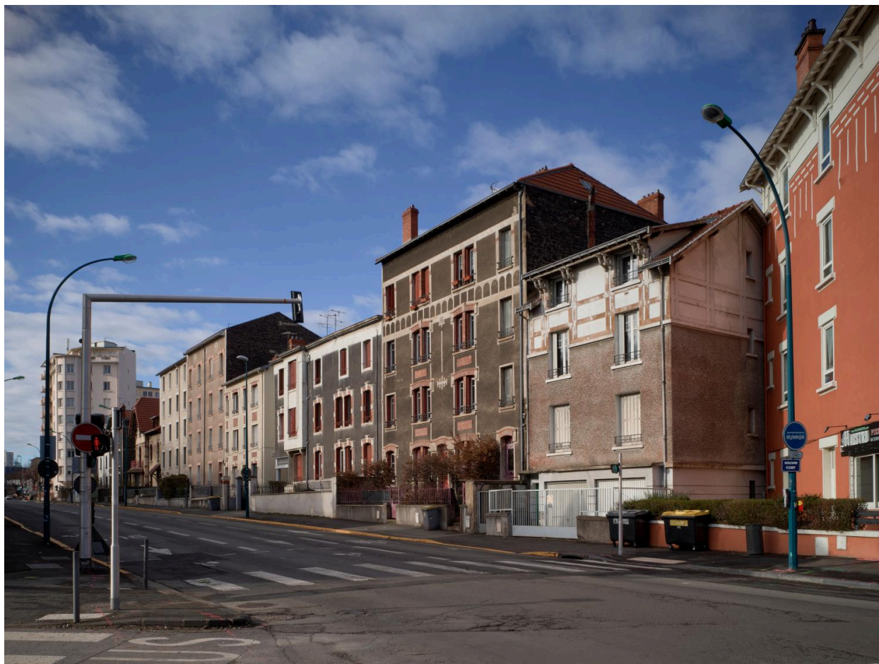
Front de boulevard, vue depuis le nord
