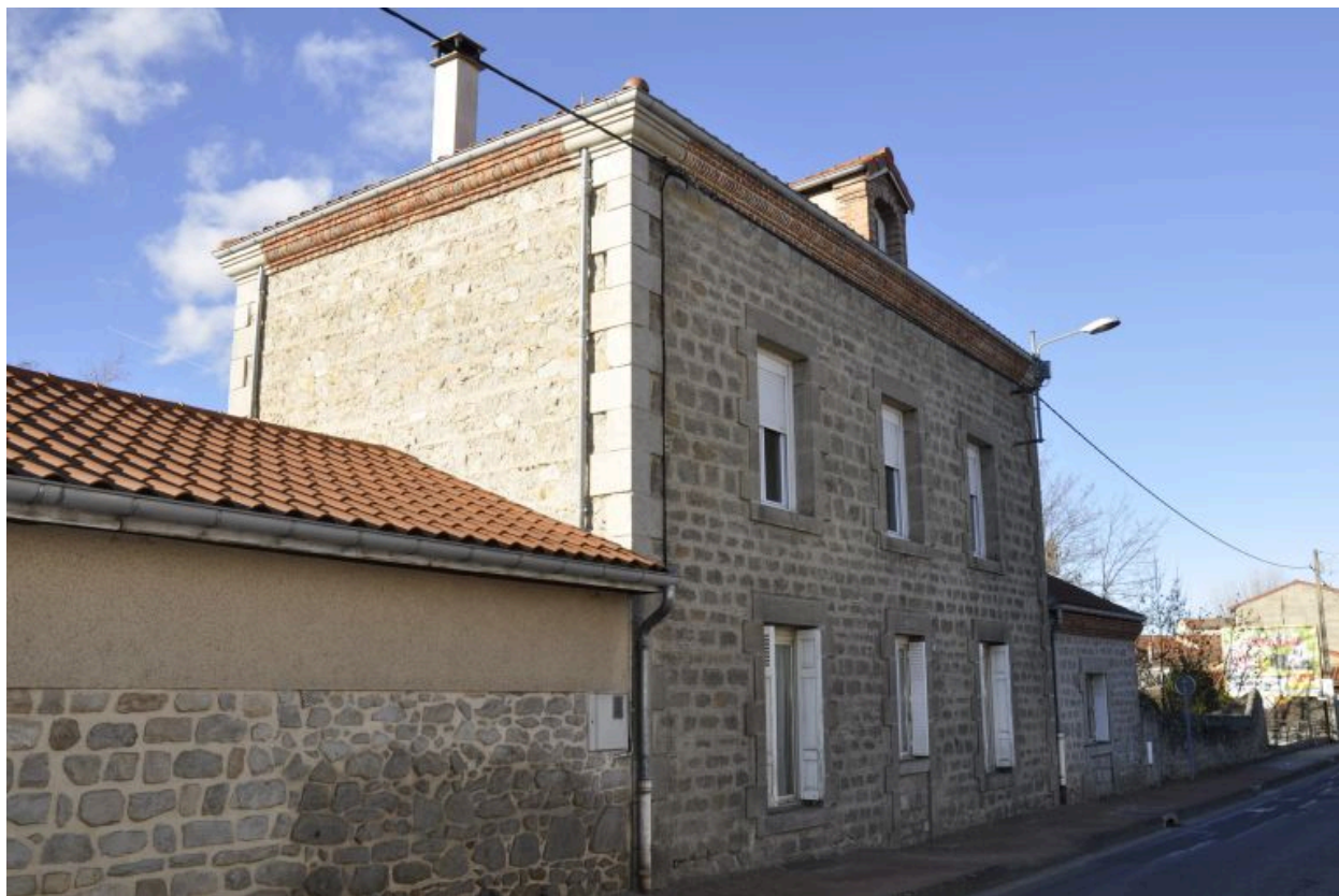
1986 AS 185, 186. 38, 40 rue de Saint-Anthème Maison, vue d'ensemble de la façade sur rue.
