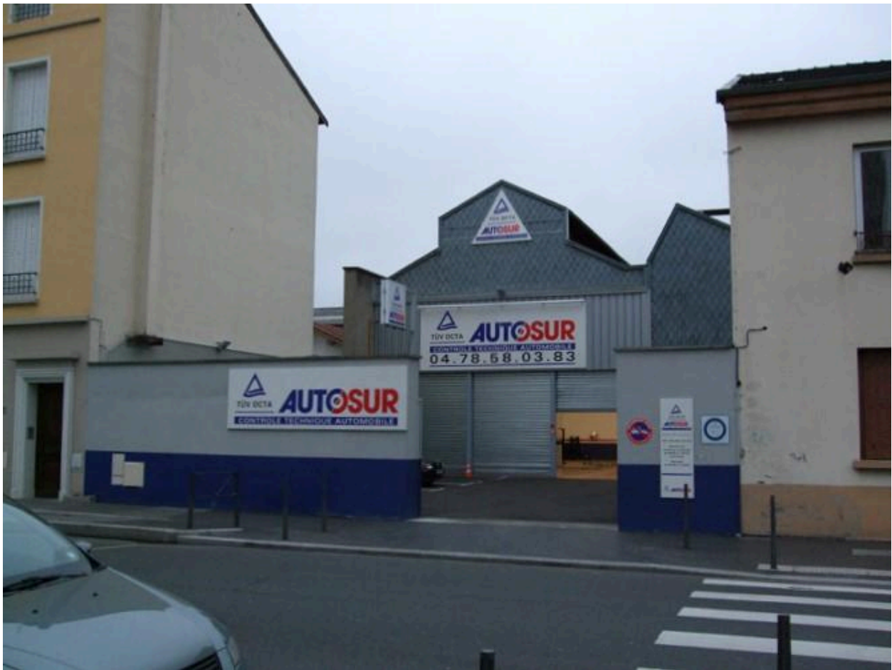
Vue d'ensemble ouest
