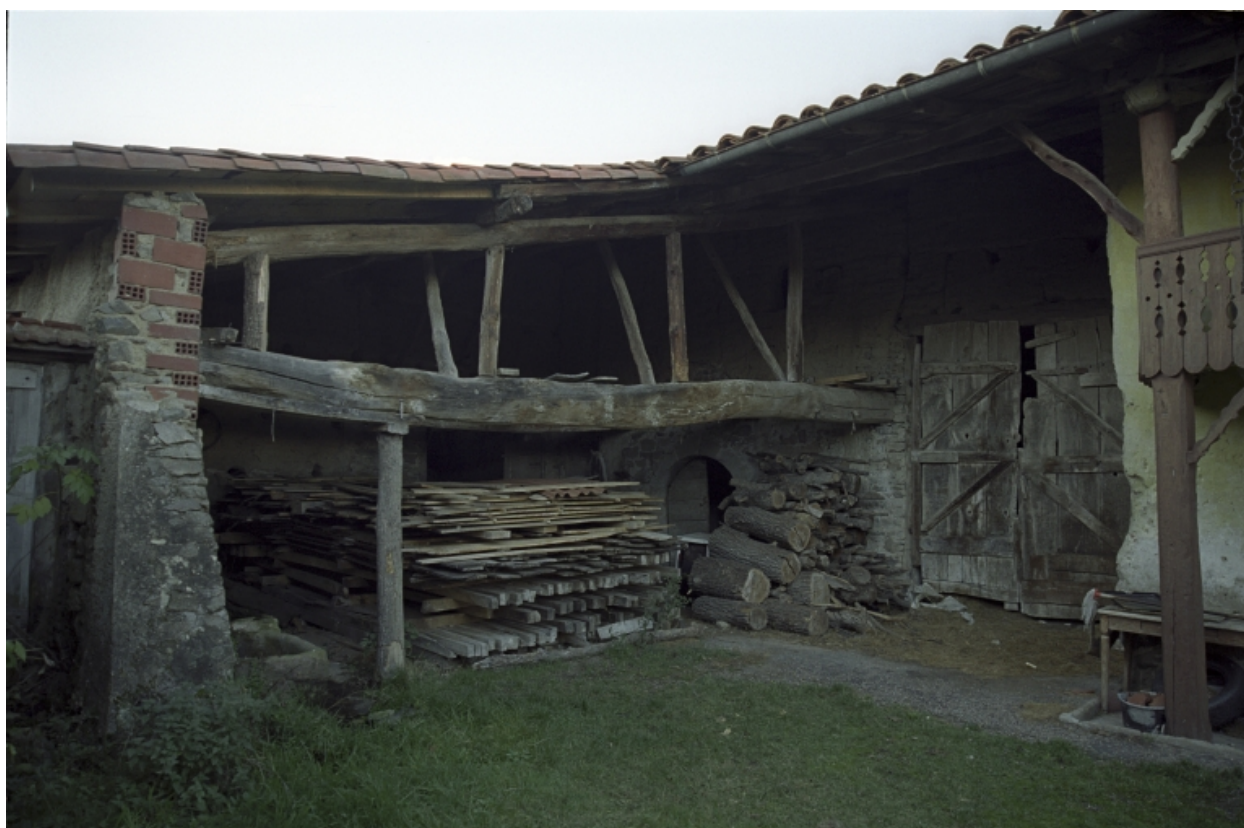
Saint-Sixte, Jay (1987 A3 884), type C2. Vue d'ensemble du cuvage et du hangar.
