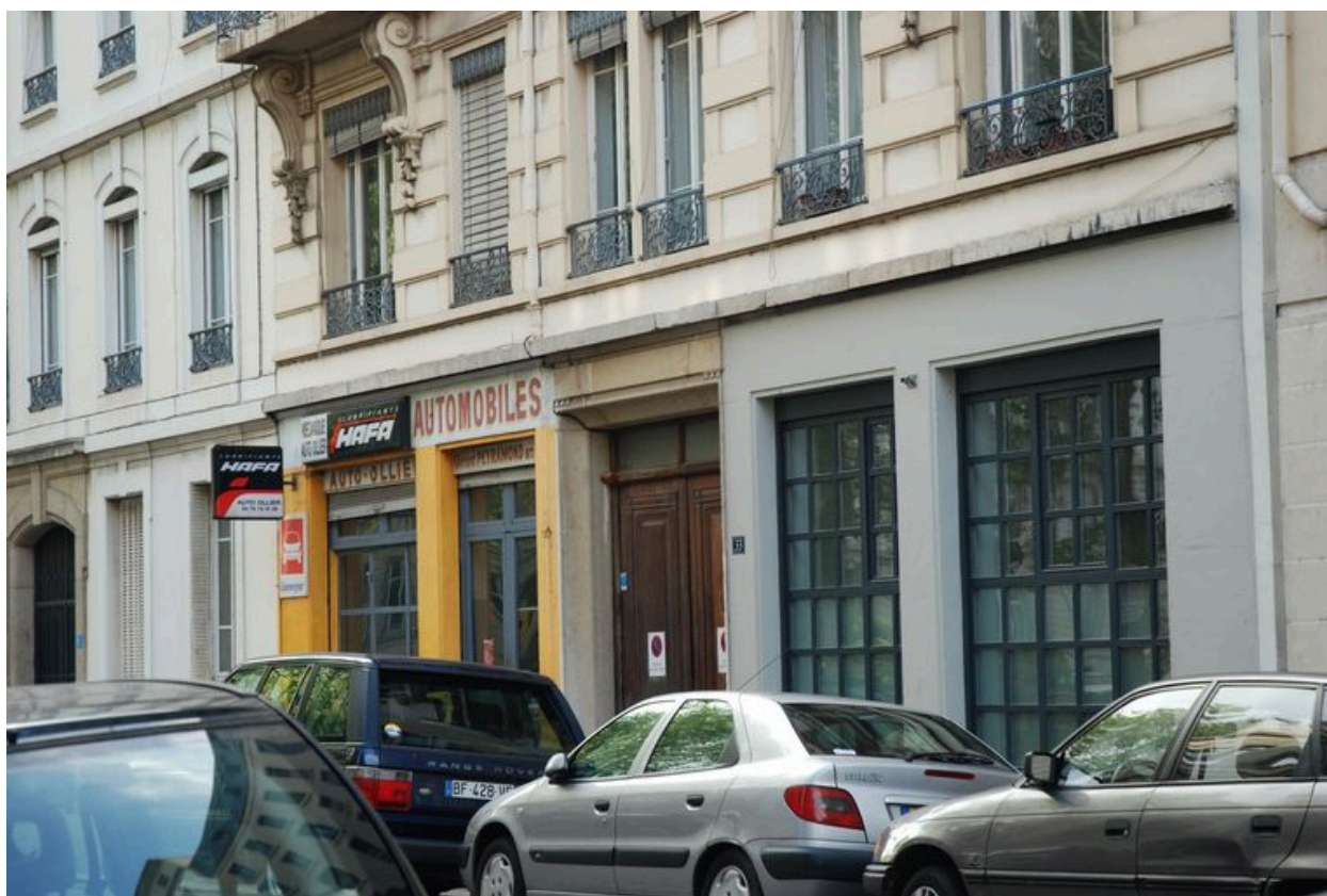
Vue du rez-de-chaussée, après transformation
