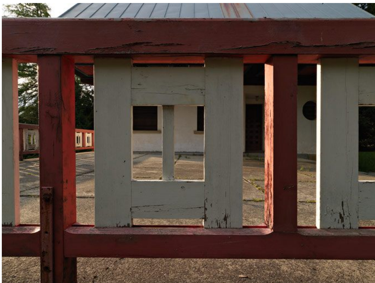
Détail du garde-corps de la terrasse
