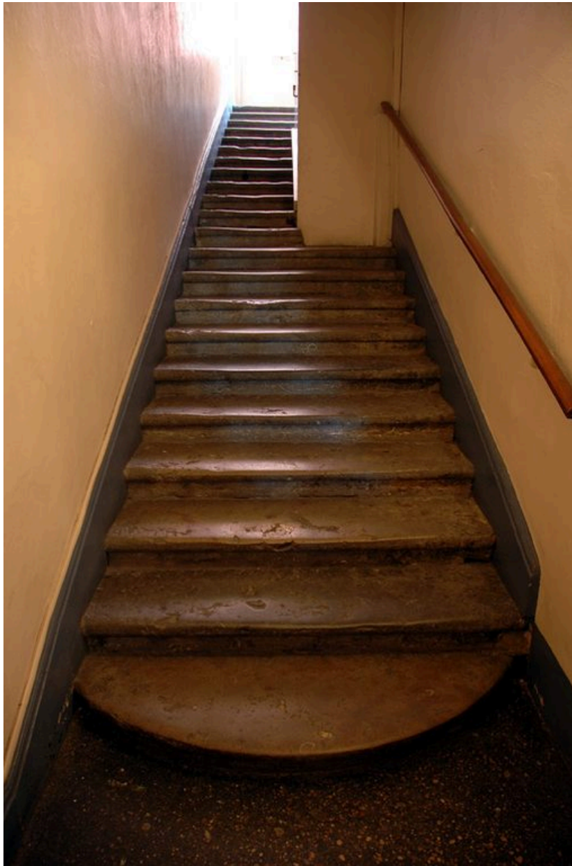
Départ de l'escalier principal
