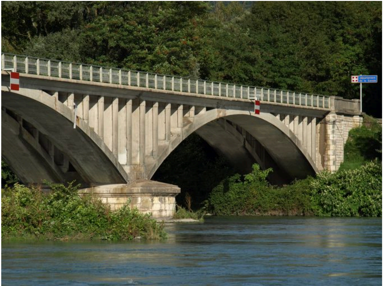
Vue partielle, arche et culée droite, face amont (depuis la rive gauche)
