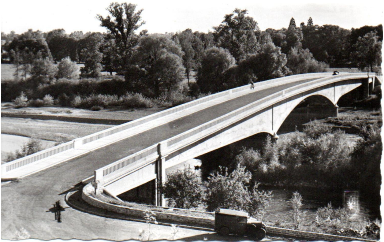
Vue du 3e pont, photographie (s.n., s.l) années 1960.
