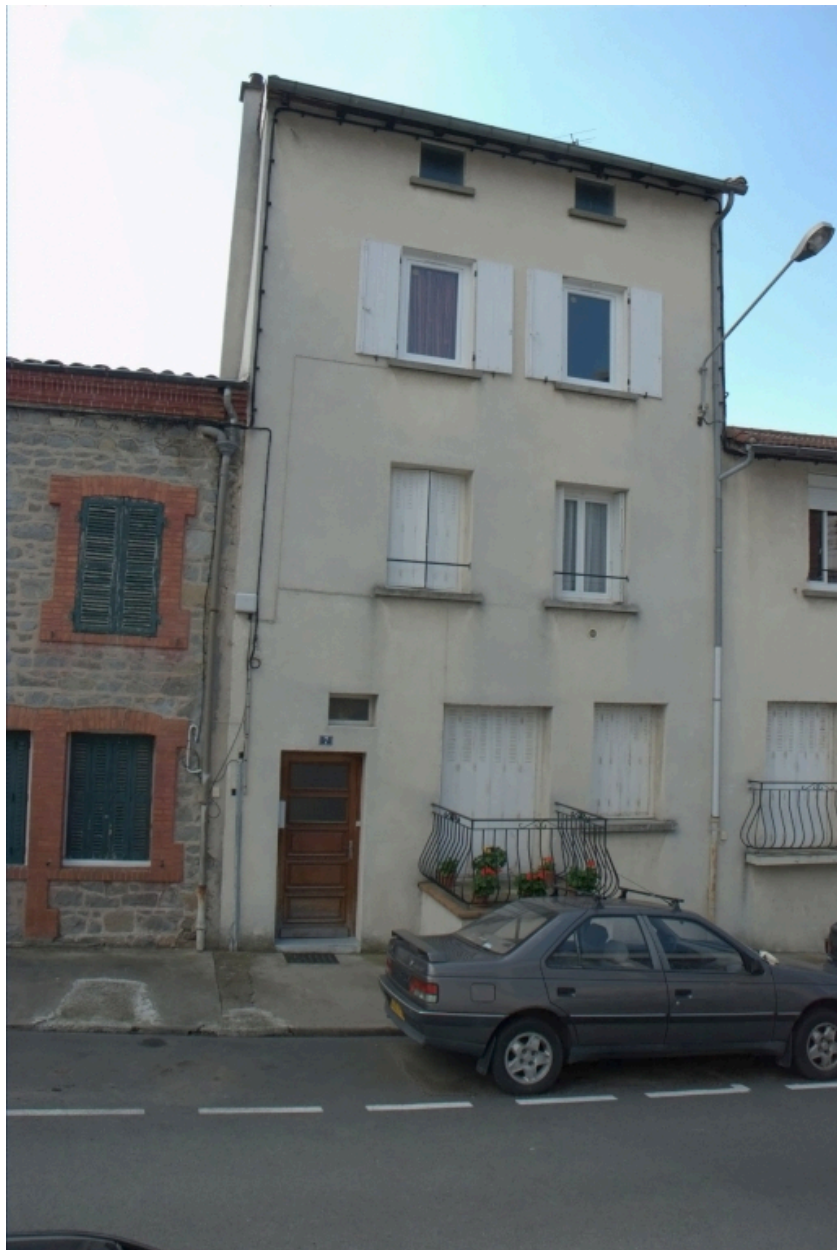
Îlot 3. Sordet (rue du) 07? Vue générale de la façade sur rue.
