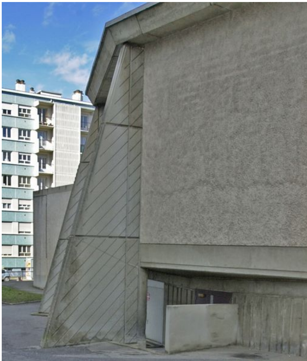
Détail des contreforts du chevet
