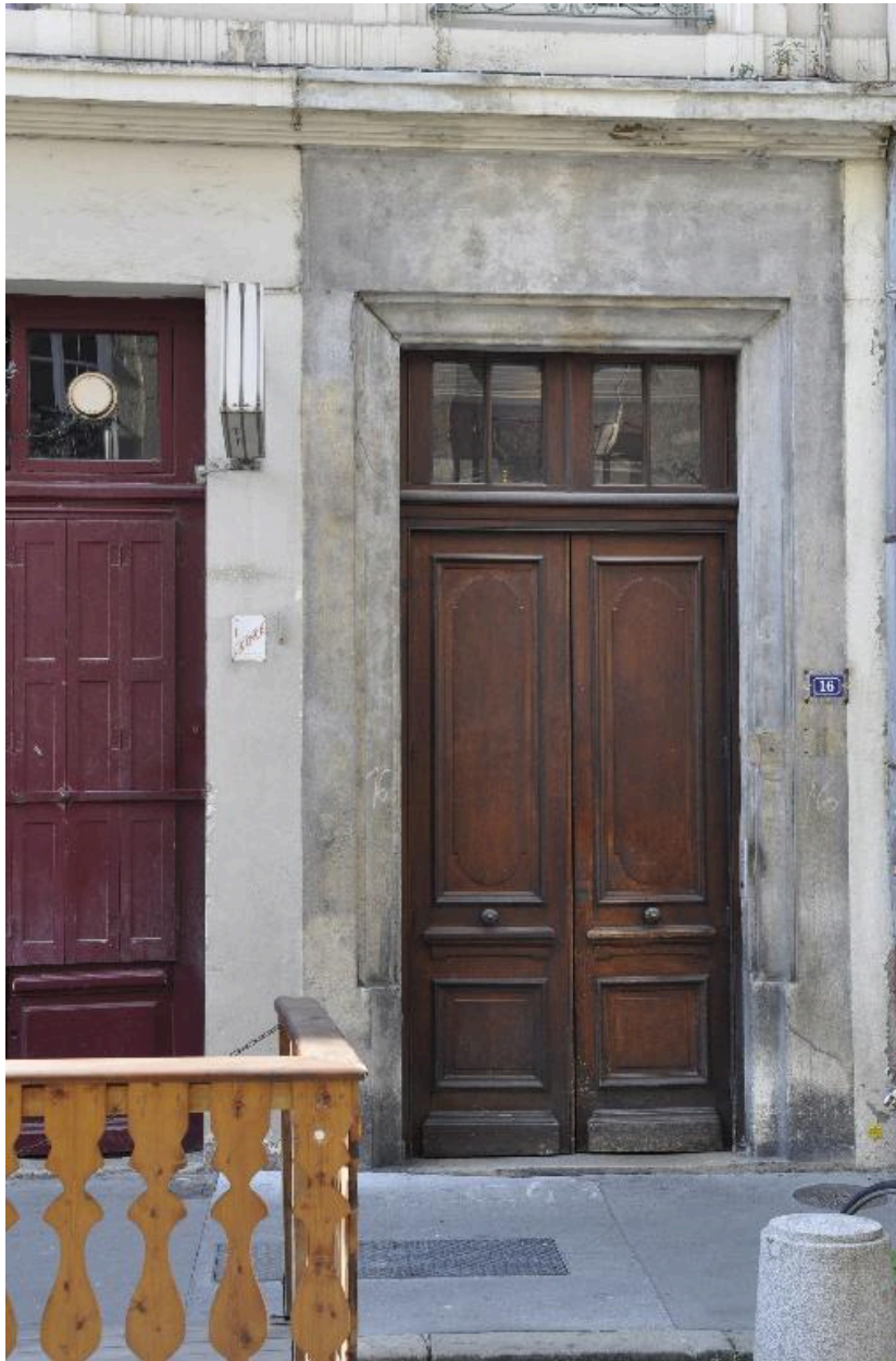
Vue rapprochée de la porte d'entrée
