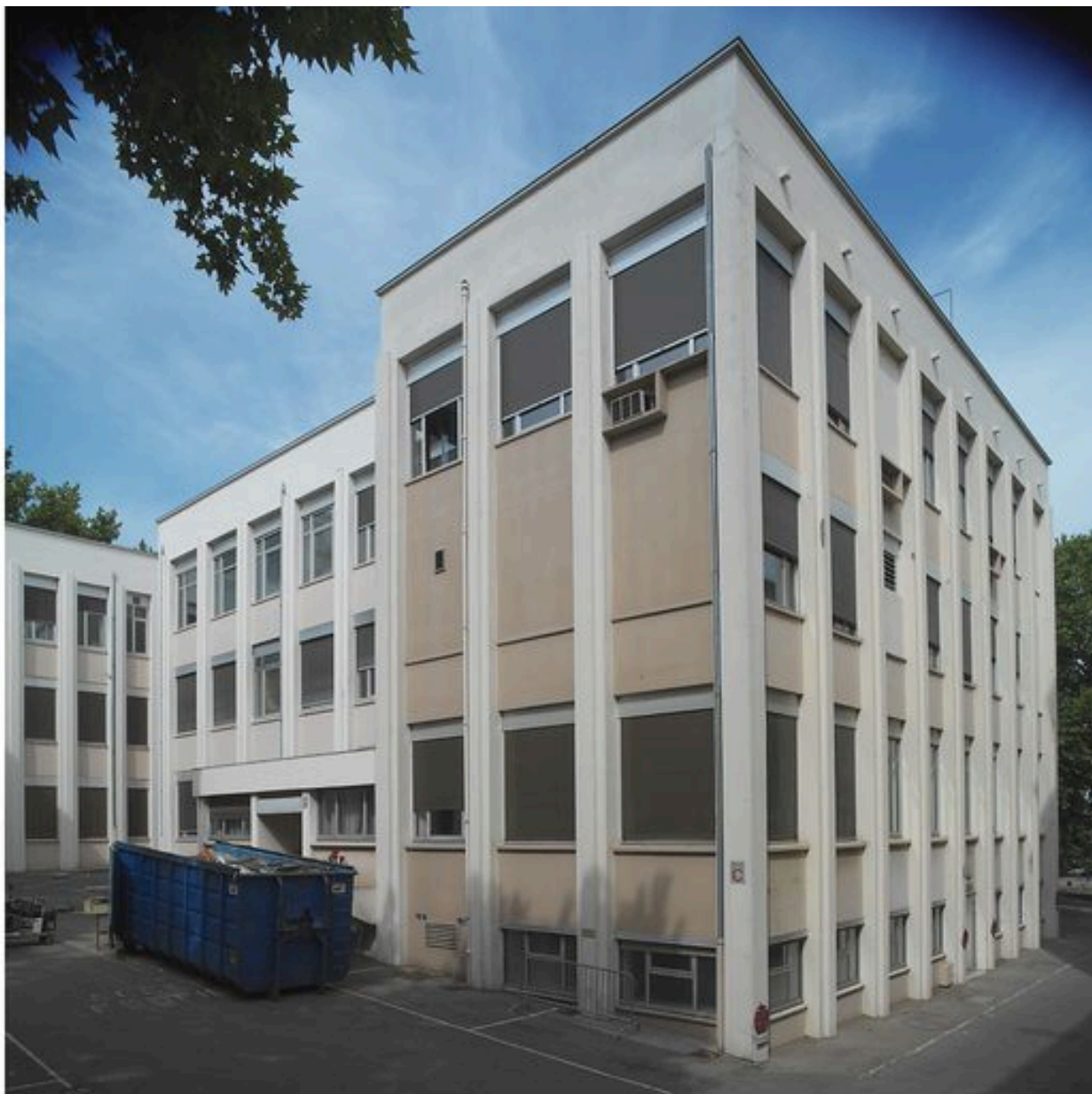
Pavillon Blanche-Herriot (17), aile centrale vue depuis le côté est
