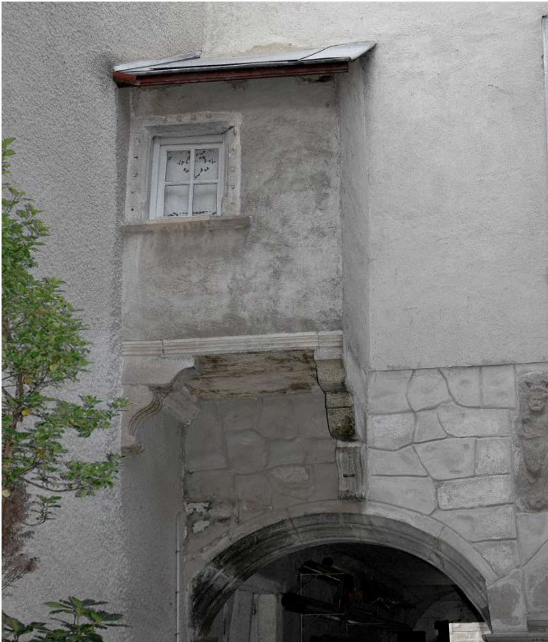
Logette au-dessus du corps de passage.
