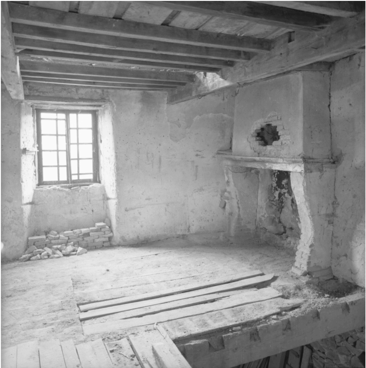
Vue intérieure du 1er étage.
