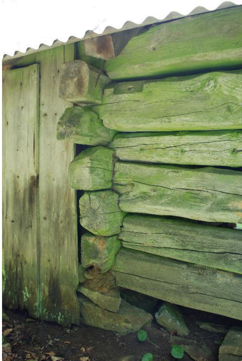
Détail de la mise en oeuvre des madriers et du raccord avec la partie en bardage.
