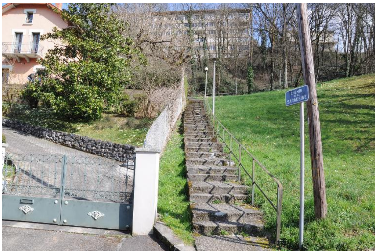
Les escaliers de la partie supérieure, vue vers l'est
