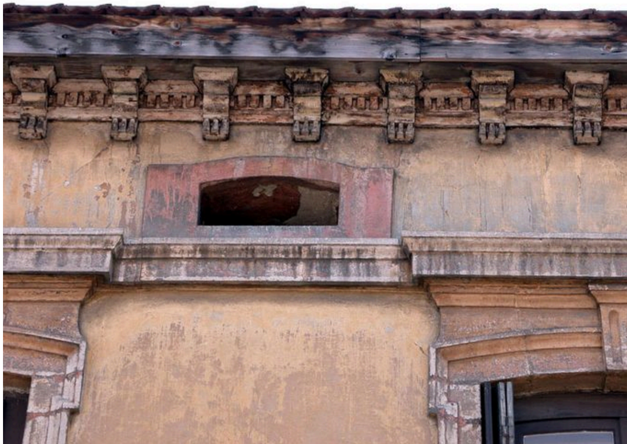
Détail d'une baie libre du comble et de la corniche
