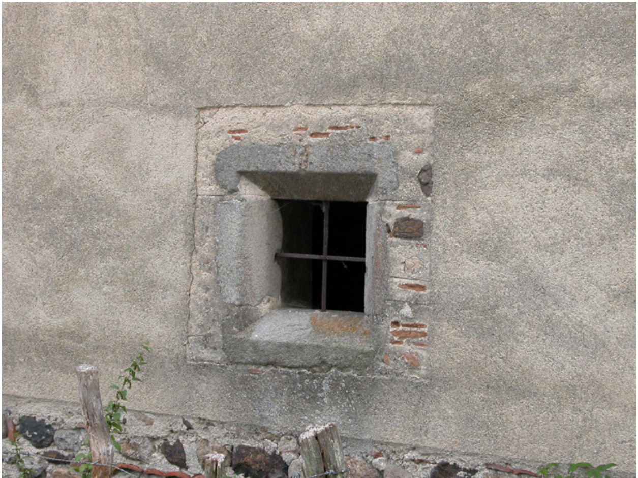
Détail d'une fenêtre à encadrement chanfreiné, en remploi sur la façade nord du logis (jour de la cave).
