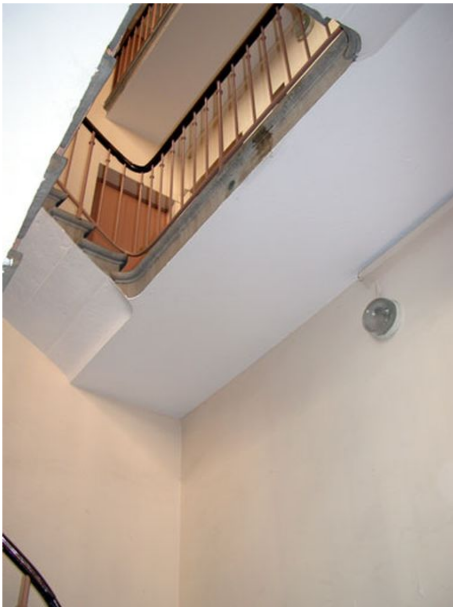
Vue de la cage d'escalier
