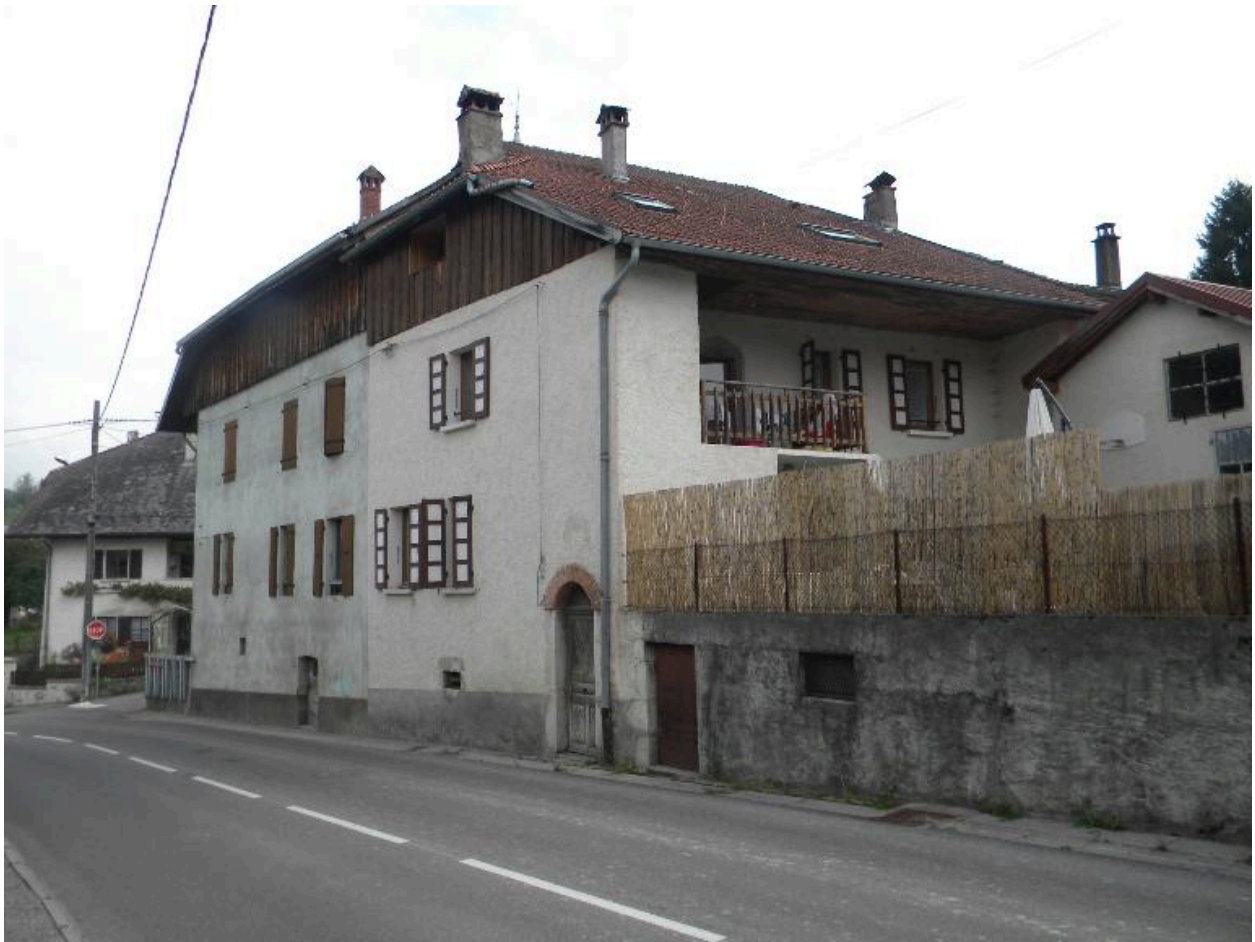
Vue de la façade principale d'une ancienne maison (2008 E2 164)
